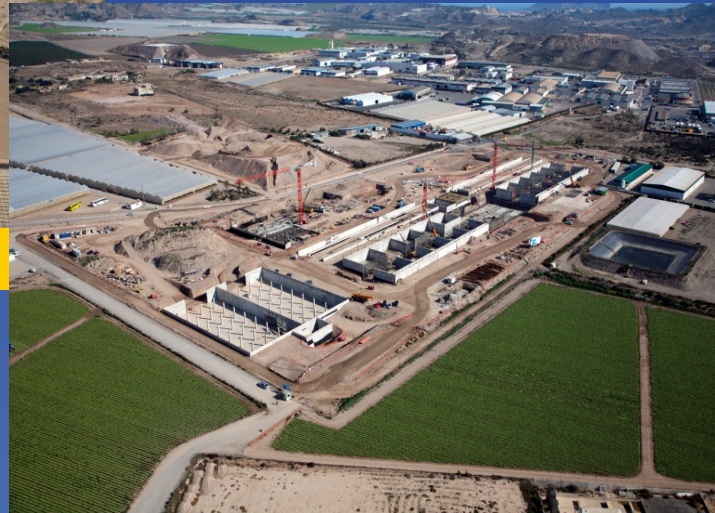
Estado actual de las obras
