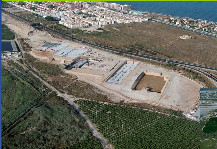
Inicio de las obras en febrero de 2007
