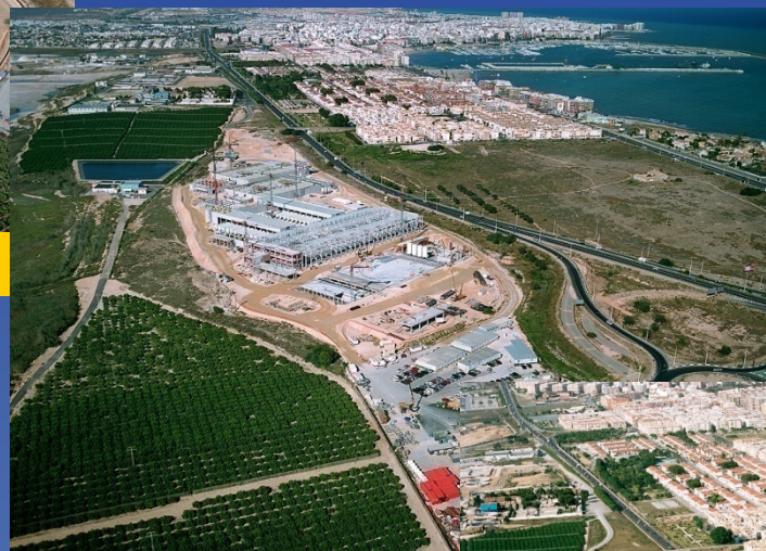
Estado actual de las obras
