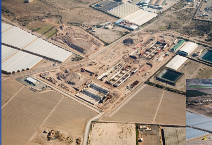
Inicio de las obras en junio de 2007
